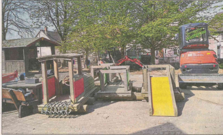
In der Kita in Ruppertsburg sind die Bagger ordentlich im Einsatz, um die Außenanlagen für das 50-jährige Bestehen im kommenden Jahr herzurichten.
