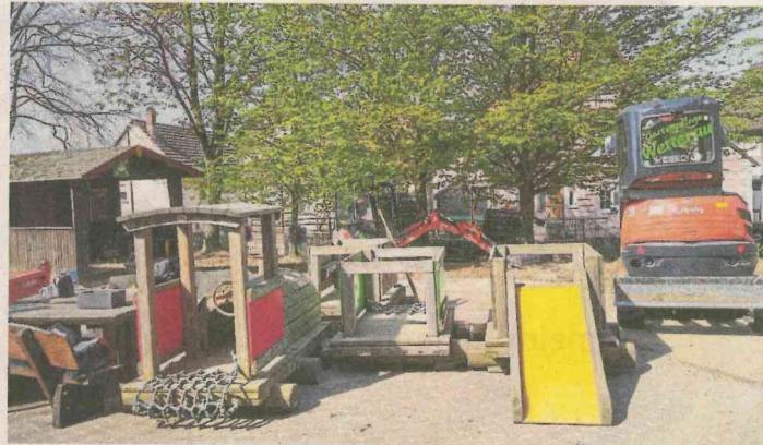
In der Kindertagesstätte in Ruppertsburg werden derzeit die Außenanlagen erneuert.
